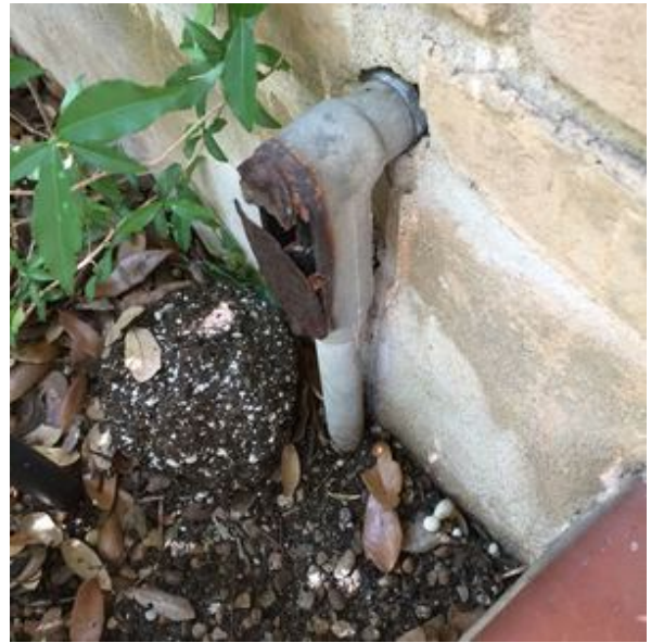
REPLACE CONDUIT PLATE
